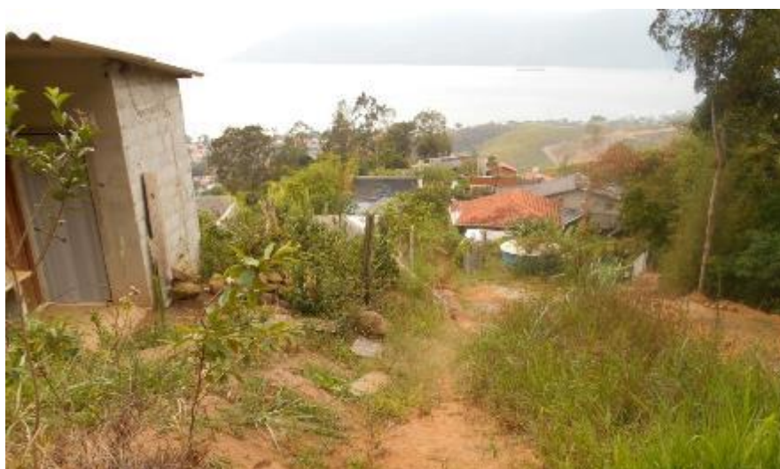
Figura 13. Construções irregulares no Morro do Abrigo.
