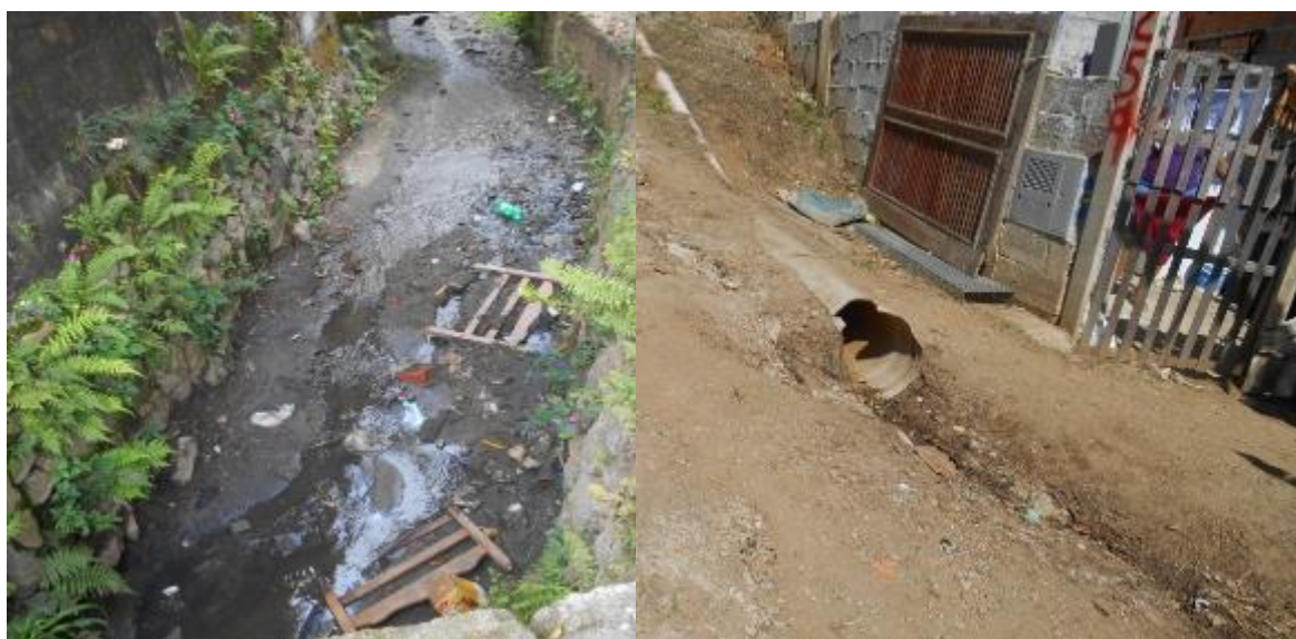
Figura 27 e 28. Esgoto a céu aberto no Morro do Abrigo.
